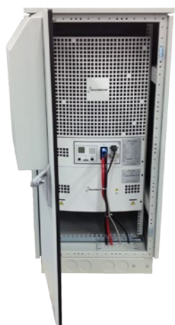
Рис. 9. ЭУ с ПОМТЭ мощностью 60 кВт на водороде фирмы Ballard, США – Канада [6]
